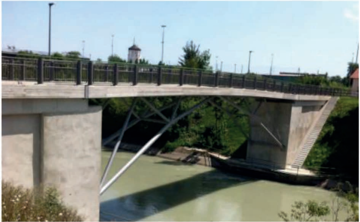
Fuß- und Radwegbrücke Mühldorf a. Inn
