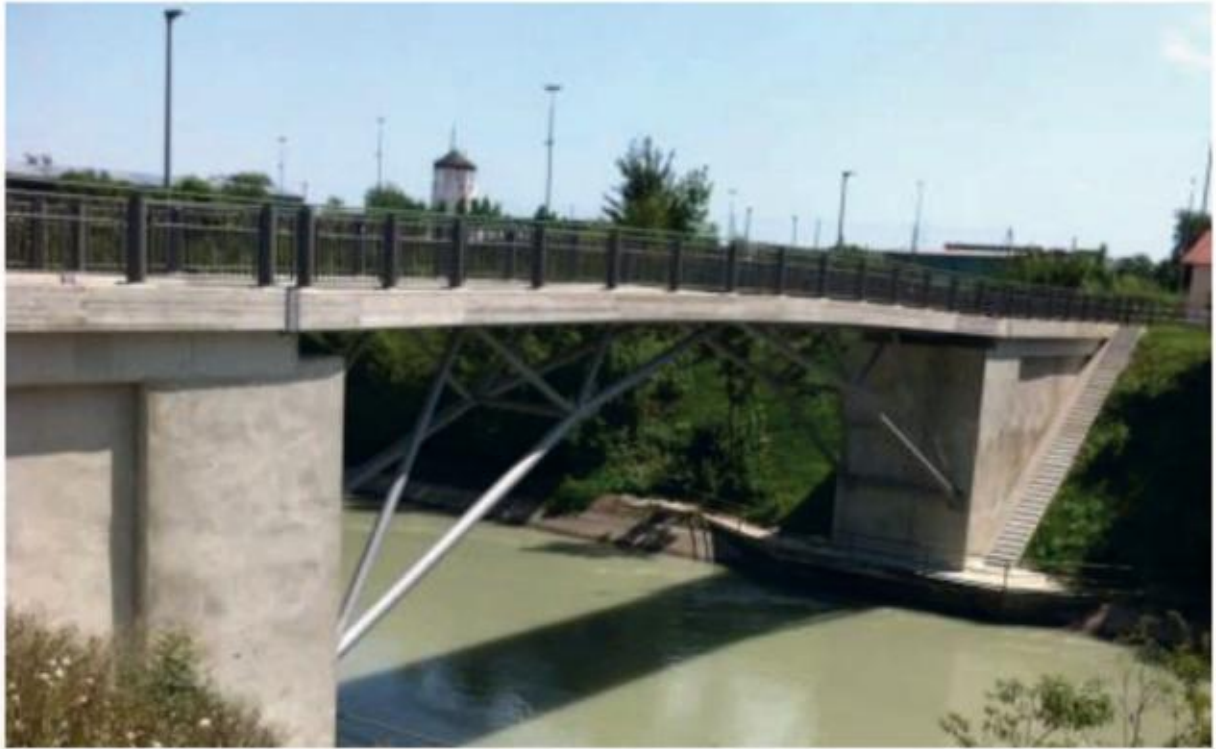
Fuß- und Radwegbrücke Mühldorf a. Inn
