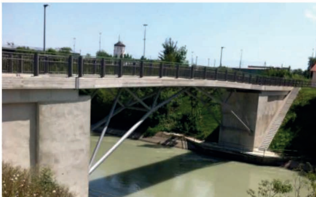
Fuß- und Radwegbrücke Mühldorf a. Inn
