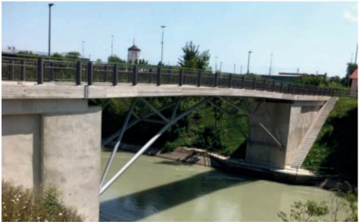
Fuß- und Radwegbrücke Mühlendorf a. Inn
