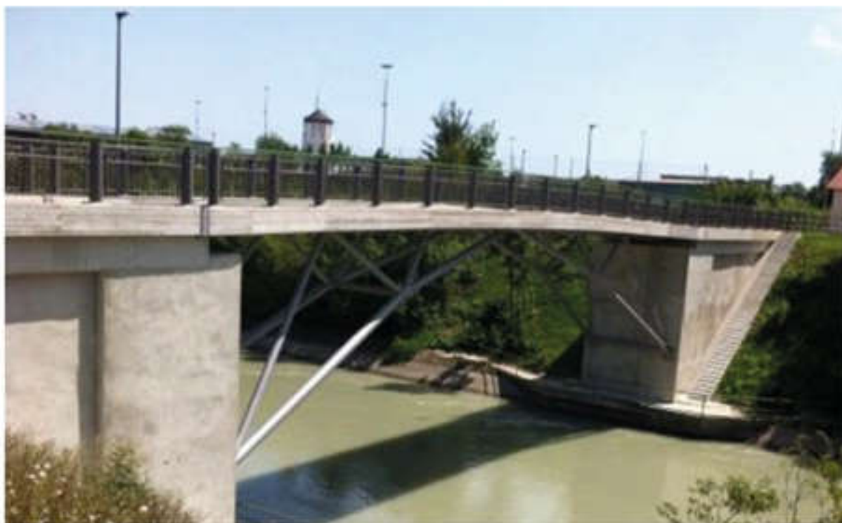
Fuß- und Radwegbrücke Mühldorf a. Inn
